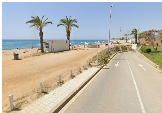
Vista del paso subterráneo de acceso al camino paralelo a la playa de Levante.
